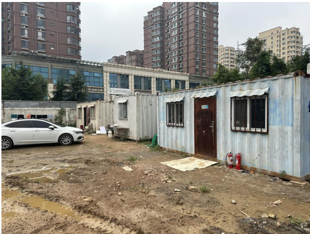
图 2.2-1 施工管理板房
