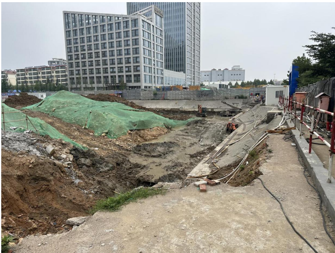
图 2.2-2 施工道路硬化
