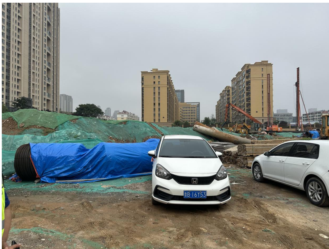
基坑开挖土石方进行防尘网覆盖（拍摄时间：2024 年 8 月）
