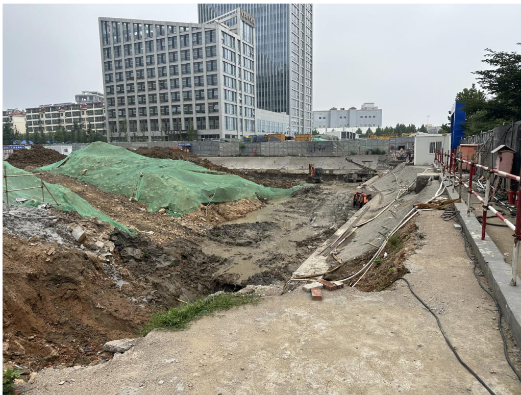
东北侧基坑开挖（拍摄时间：2024 年 8 月）
