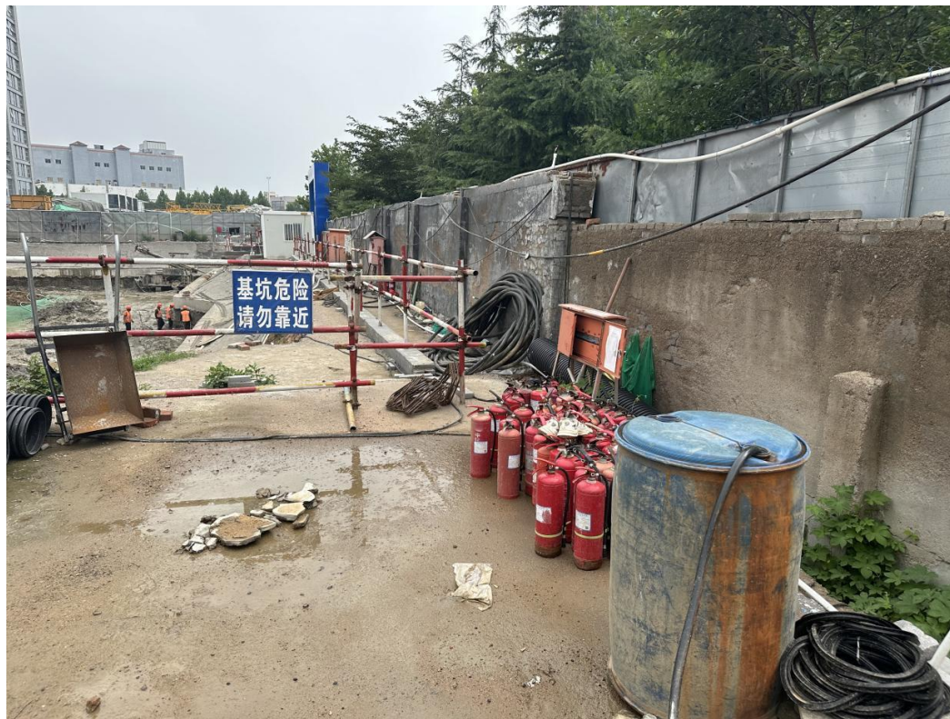
基坑挡水台（拍摄时间：2024 年 8 月）
