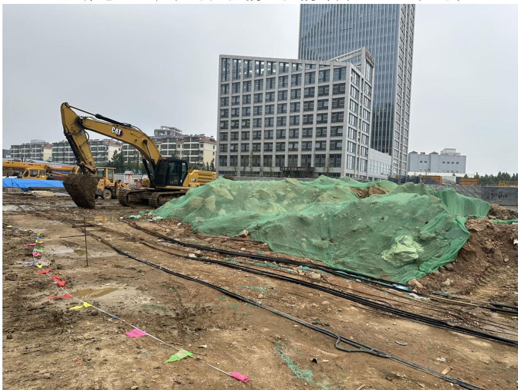
开挖土石方进行防尘网覆盖（拍摄时间：2024年8月）
