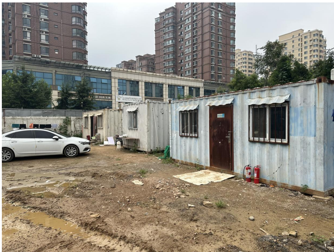
施工管理板房（拍摄时间：2024 年 8 月）
